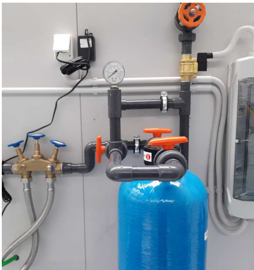
Detailní obrázek napojovací hlavy mix-bed filtru Aquaclear
