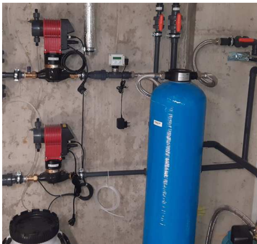
Detailní obrázek napojovací hlavy mix-bed filtru Aquaclear
